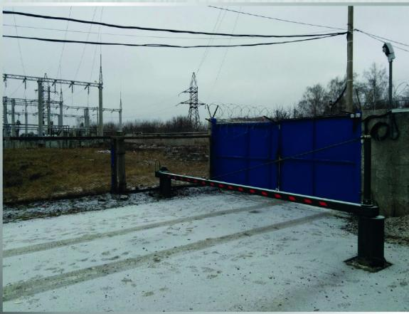
Данное противотаранное устройство перекрывает дорогу от 3 до 8 метров и изготавливается как с ручным управлением, так и с электроприводом. Усилие для открытия в ручном режиме не более 5-ти кг.
